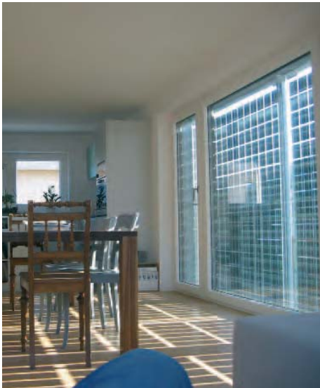
Intérieur de la villa Schmözler à Pratteln, avec ses volets coulissants munis de cellules photovoltaïques
