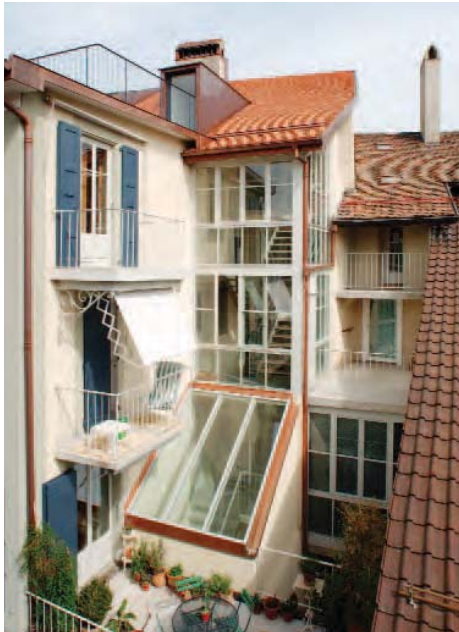
Rénovation Minergie d'un immeuble du XVI e siècle à Lutry
