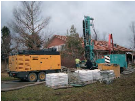
Forage pour une sonde alimentant une pompe à chaleur
