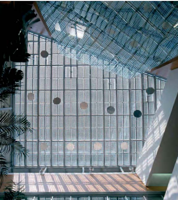
Capteurs solaires photovoltaïques semi-translucides, Plan-les-Ouates (GE)
